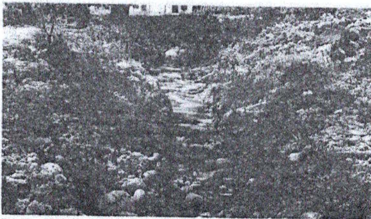
Foto 5 – Canal de conducción de las aguas residuales
