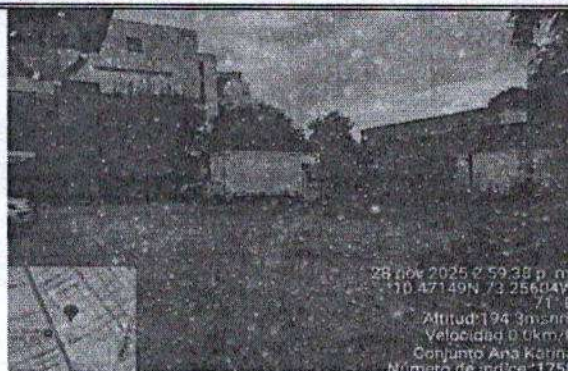
Imagen 2. Tomada desde afuera del edificio
