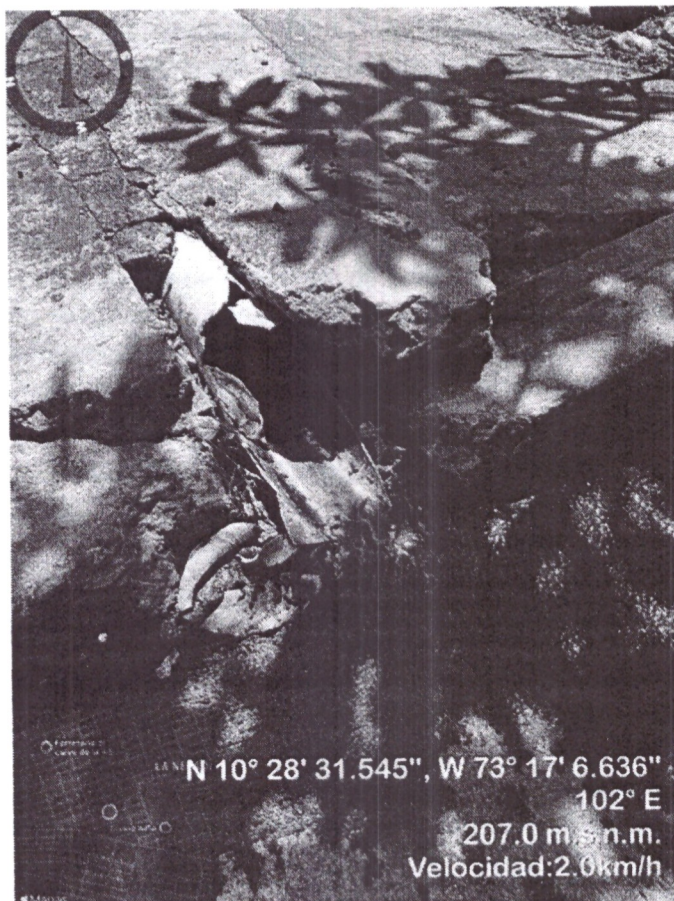
Figura 2. Desagüe de aguas pluviales de la vivienda Fuente: Propia
