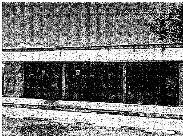
Foto No 5. Área de Cuarto de Maquinas
