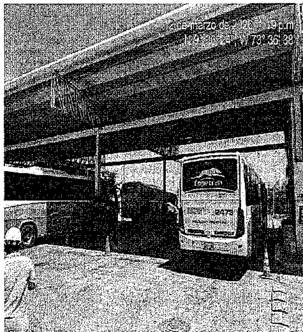
Foto No 6. Área de Mantenimiento
