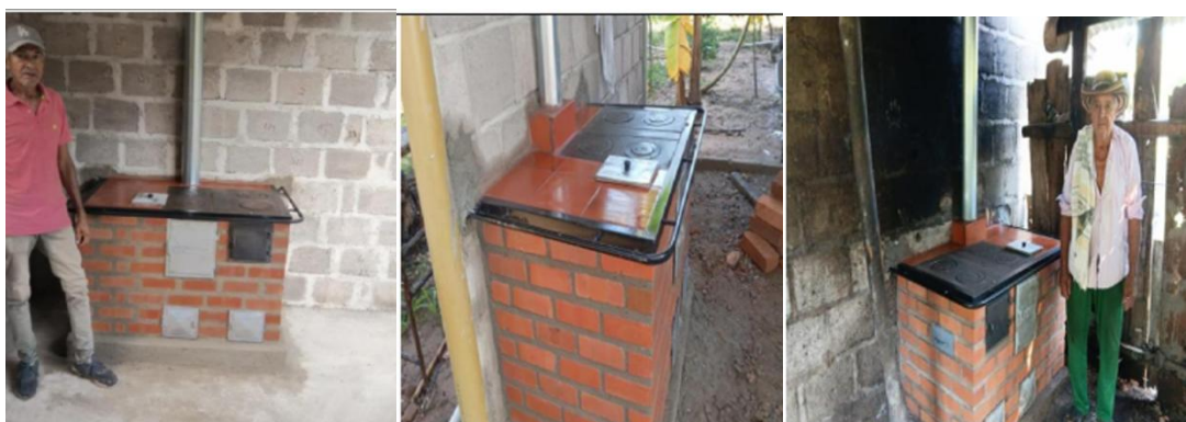
Imagen 5. Construcción de estufas
