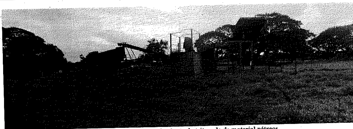
Foto 1 Vista general montaje planta de triturado de material pétreos
