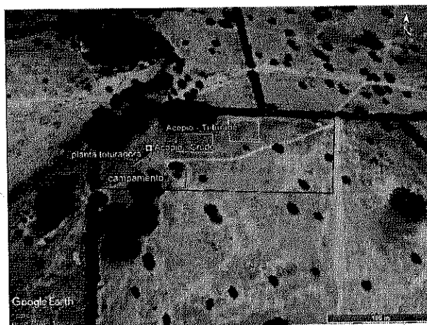
Imagen 2: Vista general infraestructura asociada al proyecto. Fuente: Google Earth Pro
