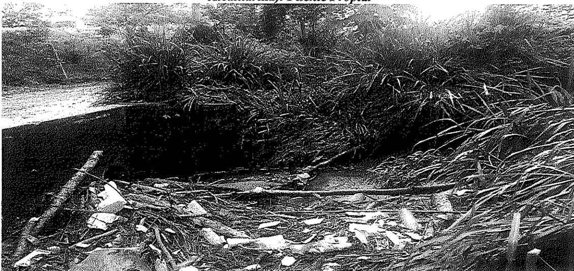
*Imagen No. 6: Condiciones en las que se encuentra el cauce del Caño Barlovento (Aguas arriba de la Alcantarilla), taponamiento por residuos vegetales. Fuente Propia.*
