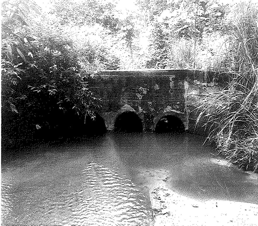
*Imagen No. 3: Estructura hidráulica existente (Alcantarilla Triple de 24"). Fuente Propia.*
