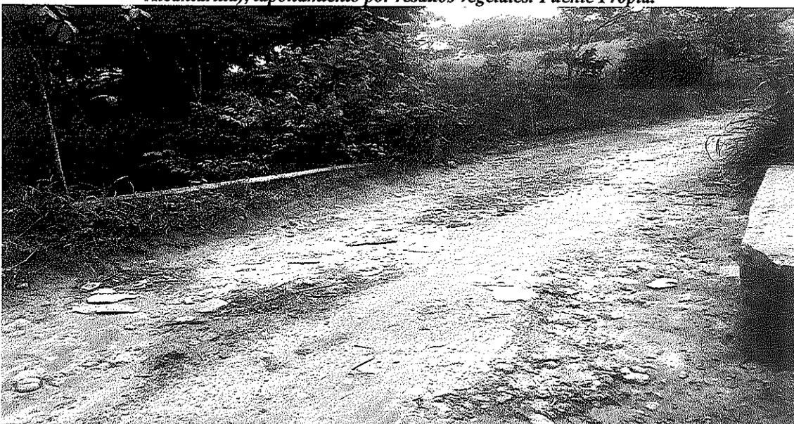
*Imagen No. 7: Condiciones en las que se encuentra el afirmado de la actual estructura hidráulica (Alcantarilla Triple de 24"). Fuente Propia.*
