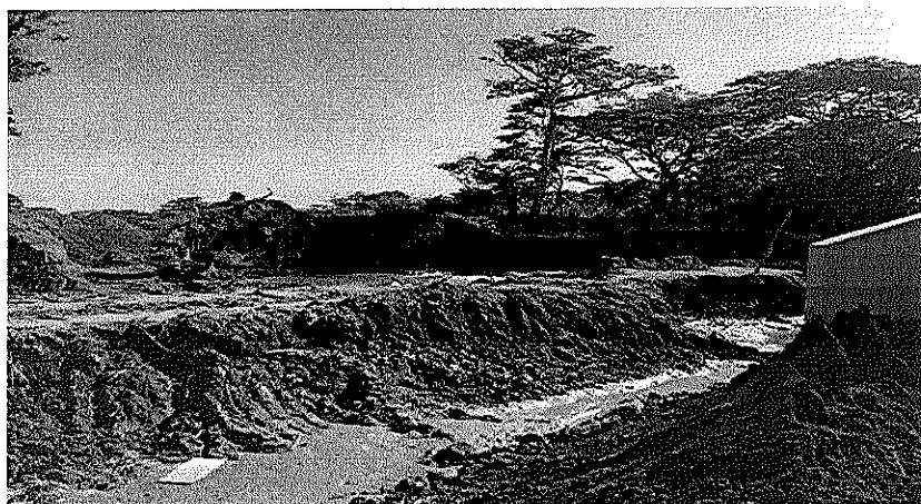
Ilustración 5. Zanja lateral a estructura box culvert construida en el sitio autorizado de la ocupación.
