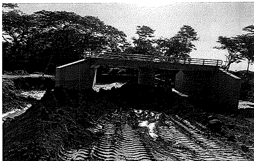
Ilustración 6. Estructura box culvert construida en el sitio autorizado de la ocupación, sentido aguas arriba del Río Magiriaimo.
