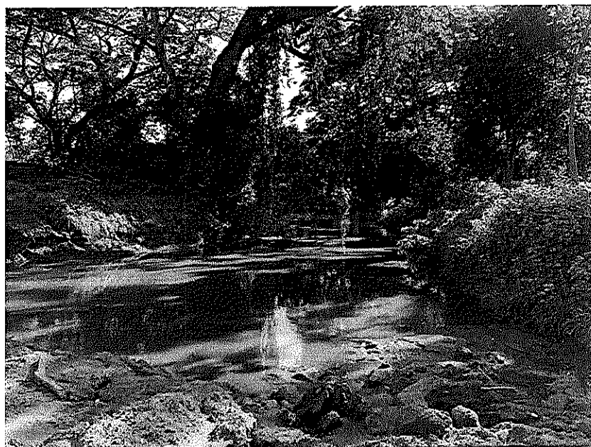
Ilustración 7. Corriente de Río Magiriaimo antes de Estructura box culvert construida en el sitio autorizado de la ocupación.
