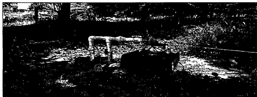
Imagen 2. Punto de captación. Fuente: Propia
