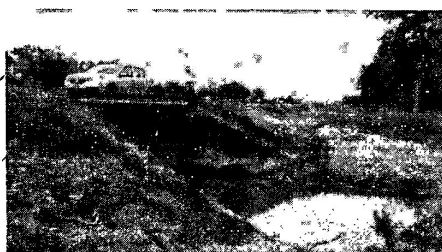
Cauce “Innominado” 73°32'40.80" O 9°24'39.70" N - vía San Roque - Bosconia Tramo 1
