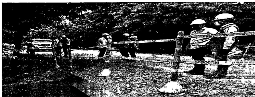
Ilustración 2. Diligencia de inspección técnica en proyecto de interés de ocupación.
