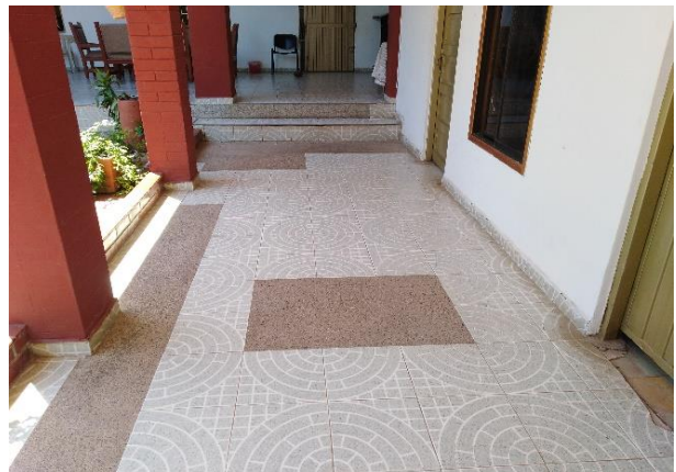
Foto 8. Detalle arreglos piso casa parroquial
