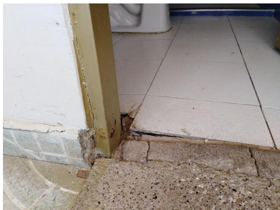
Foto 10. Detalle levantamiento pisos baño casa parroquial
