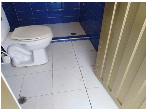
Foto 9. Piso baño casa parroquial levantados
