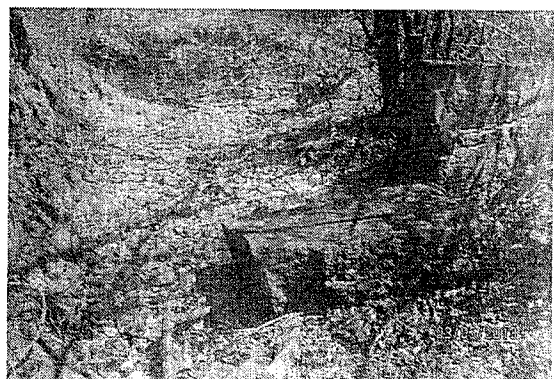
Muro de contención de las aguas del canal Escalona, construido sobre un drenaje natural, se encuentra derribado, ésta obra se ubica en el predio El Tunal
