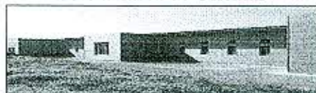
Foto 1. Área de Oficinas
