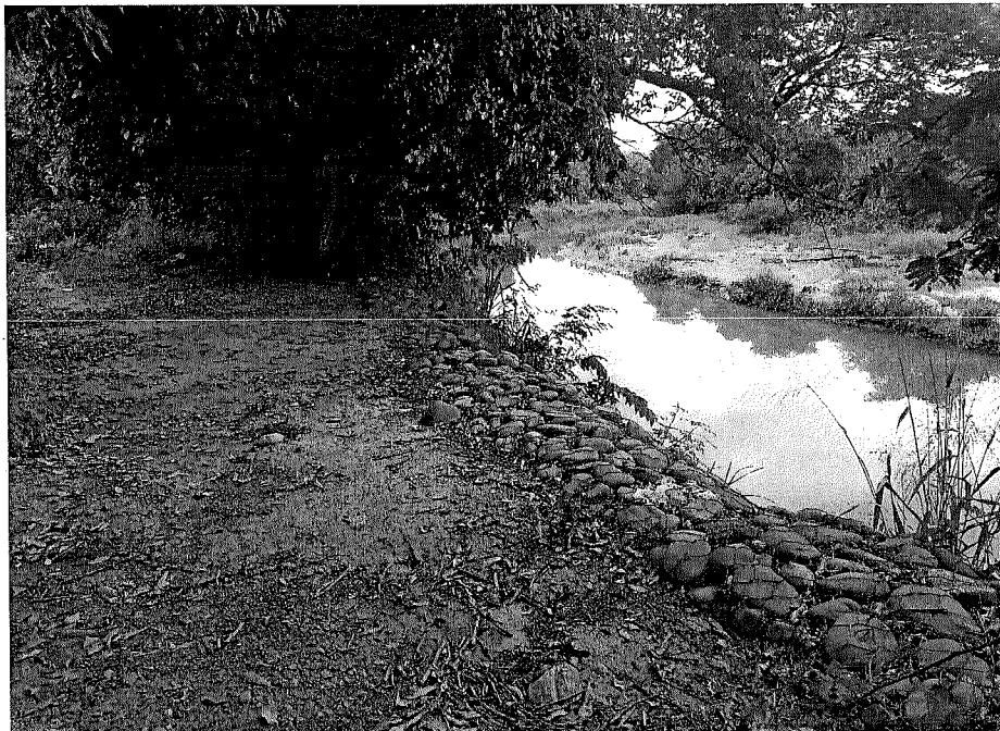
Imagen No. 22: Margen del Río Maracas a intervenir en las actividades constructivas del Tramo No. 1, (Gaviones contruidos). Fuente Propia.
