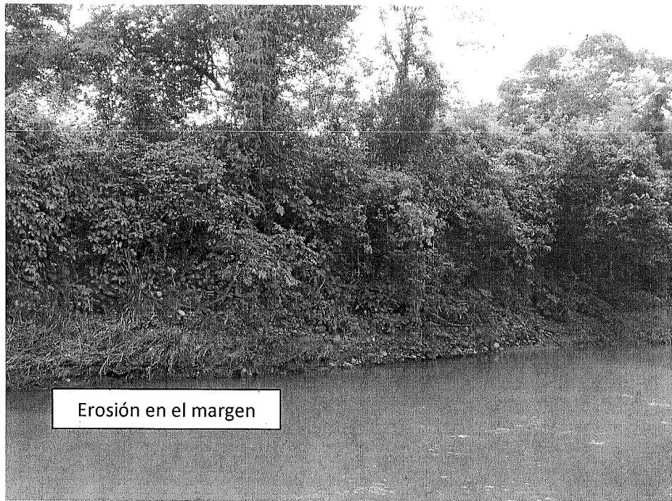
Imagen No. 7: Margen del Río Maracas a intervenir en las actividades constructivas del Tramo No. 1, (evidencia de erosión). Fuente Propia.
