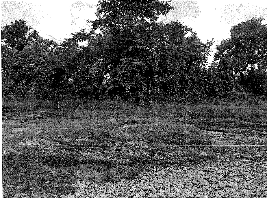
Imagen No. 21: Margen del Río Maracas a intervenir en las actividades constructivas del Tramo No. 1, (evidencia de erosión). Fuente Propia.
