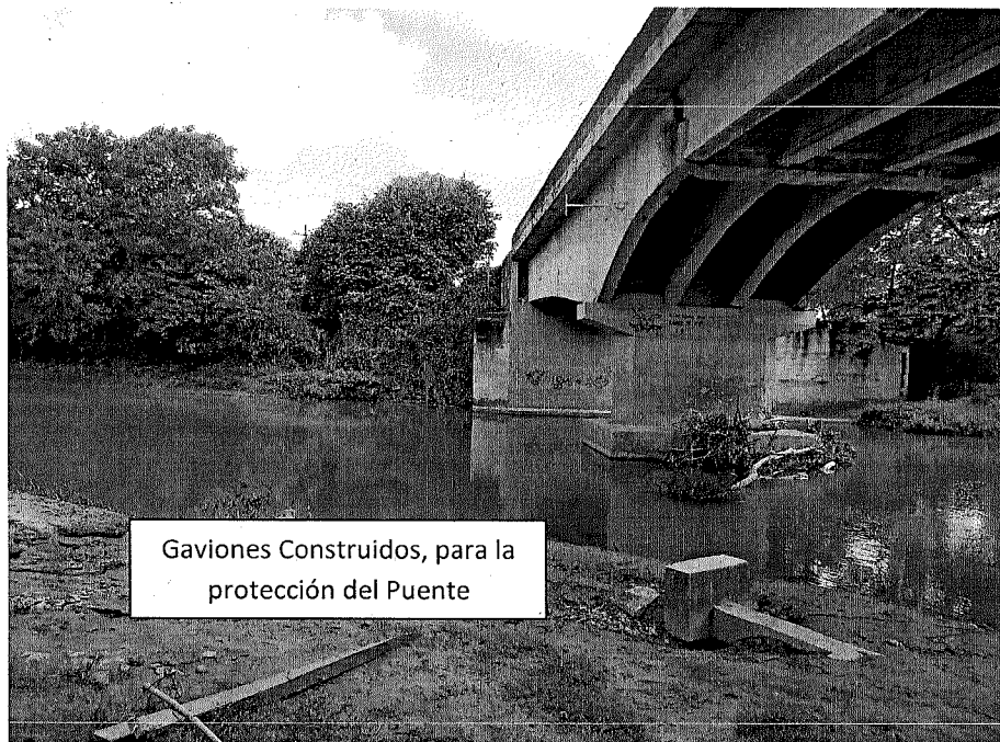
Imagen No. 18: Margen del Río Maracas a intervenir en las actividades constructivas del Tramo No. 1, (Gaviones construidos para la protección del puente). Fuente Propia.
