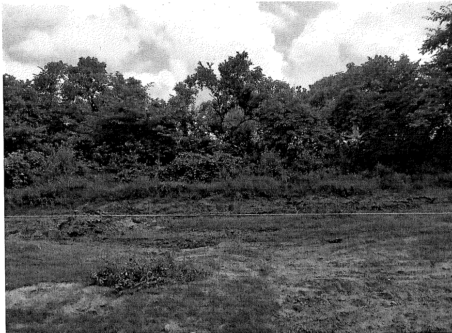
Imagen No. 20: Margen del Río Maracas a intervenir en las actividades constructivas del Tramo No. 1, (evidencia de erosión). Fuente Propia.
