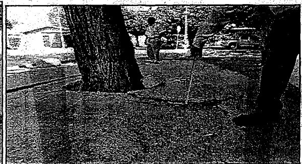
Fig. 10 y 11 Daño a obras civiles privadas con las raíces (piso fisurado y levantado).
