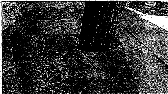
Fig. 10 y 11 Daño a obras civiles privadas con las raíces (piso fisurado y levantado).
