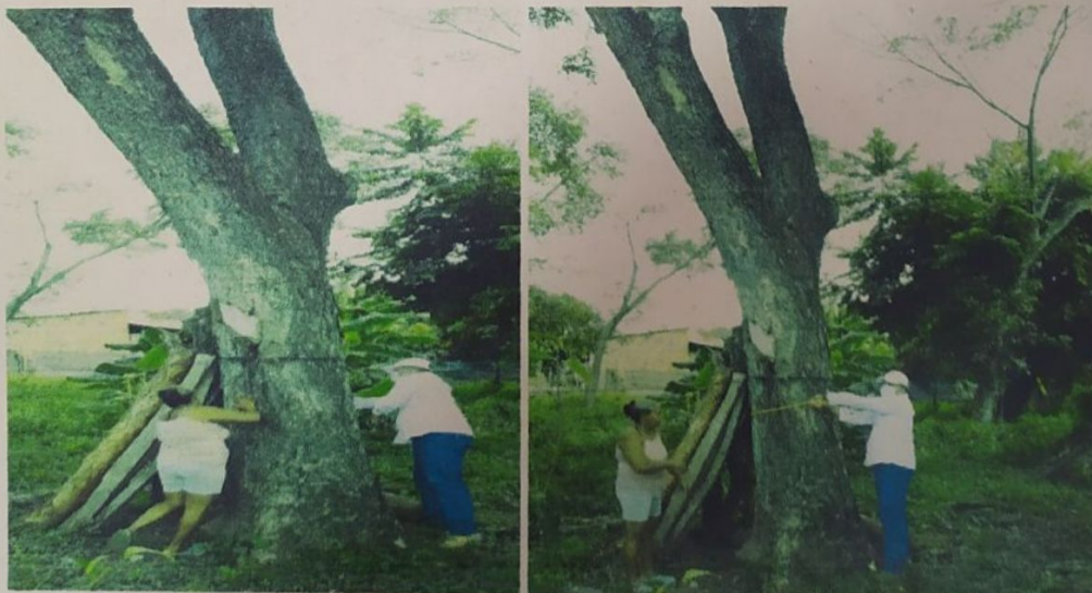
FotoN°1.Inspección de árboles de especie de campano Carrera 4 N°13-55 del barrio San José
