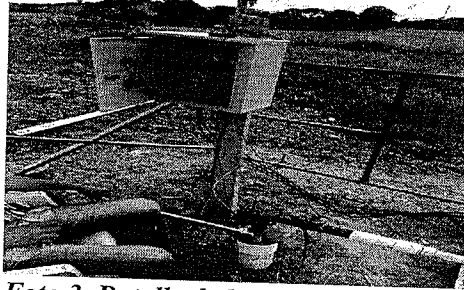
Foto 3. Detalle de la boca del pozo
