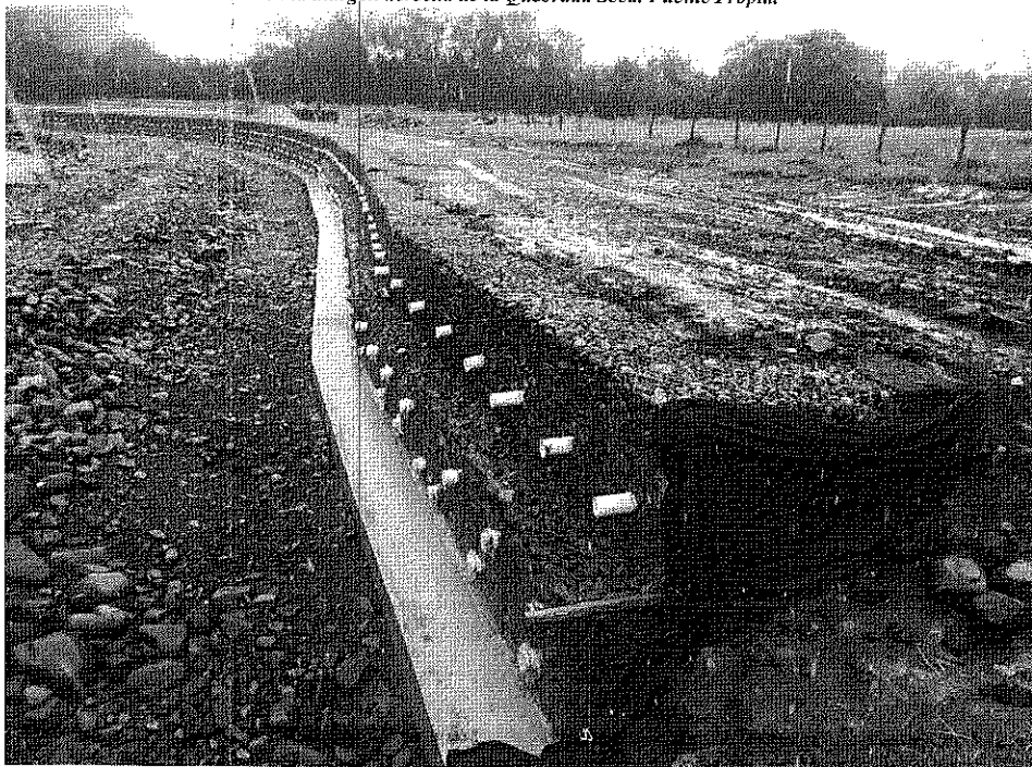
Imagen No. 12: Construcción del corredor de gavión (conformado por 70 mL y tres niveles), en la margen derecha de la Quebrada Seca. Fuente Propia.
