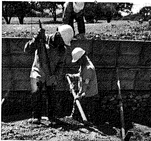
Imagen No. 17: Ejemplo de actividades de armado de formaleta. Fuente: PROCEDIMIENTO DE EJECUCIÓN DE OBRAS GEOTECNICA PK 282+188, ISMOCOL 2020.
