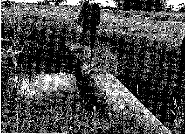
Imagen No. 12: Condiciones actuales en las que se encuentra el cauce Microcuenca denominada "Caño Cacao", así como su ronda hídrica, y la exposición del Oleoducto Ayacucho - Galán 8" PK 109 + 300 (OAG - 8"). Fuente Propia.
