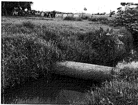
Imagen No. 10: Condiciones actuales en las que se encuentra el cauce Microcuenca denominada "Caño Cacao", así como su ronda hídrica, y la exposición del Oleoducto Ayacucho - Galán 8" PK 109 + 300 (OAG - 8"). Fuente Propia.
