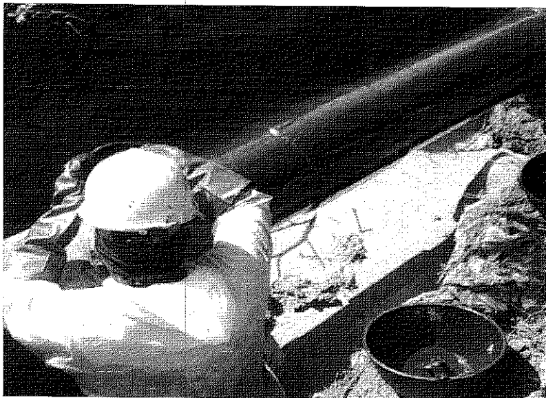
Imagen No. 14: Recubrimiento de tubería. Fuente: DOCUMENTO TECNICO - CENIT, 2019.
