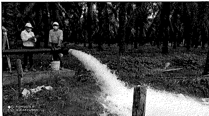
Imagen 2. Actividad de prueba de bombeo, pozo predio La Colina. Fuente: Propia
