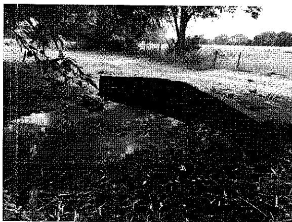
Imagen No. 6: Condiciones en las que se encuentra la alcantarilla "ALC02 - OC01A". Fuente Propia.
