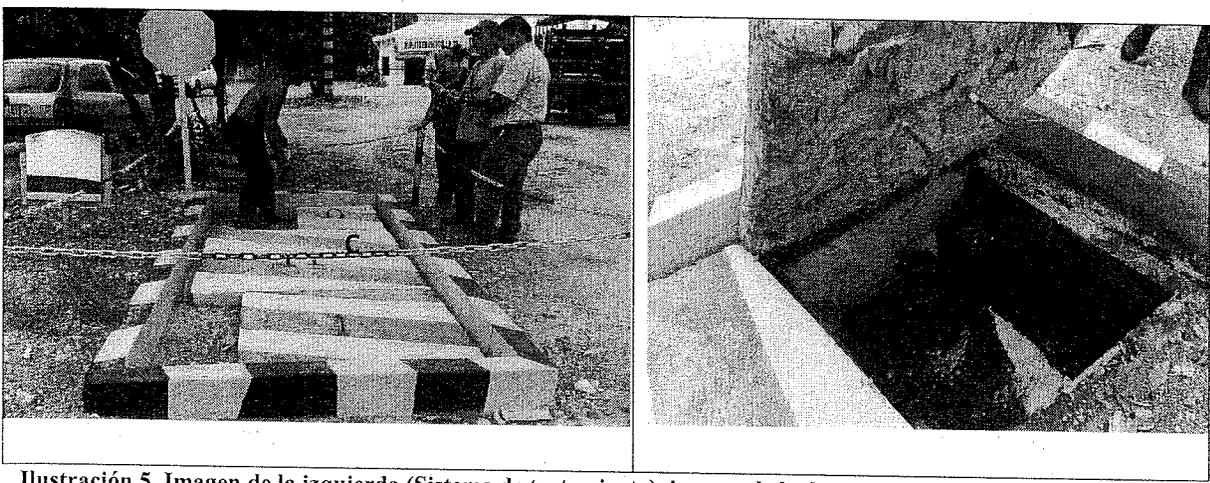
Ilustración 5. Imagen de la izquierda (Sistema de tratamiento), imagen de la derecha (desarenador), aquí llegan las aguas provenientes de la isla y el área de almacenamiento.
