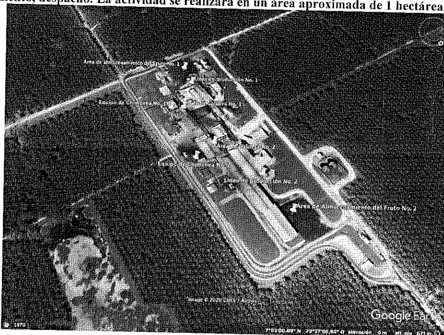
Imagen 3. Vista general, área del polígono del proyecto e infraestructuras principales asociadas
