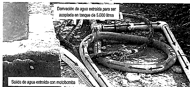
Foto 25. Sistema de recirculación agua de lavado del Mixer
