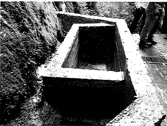
Foto 5. Detalle de la cámara de recolección en captación
