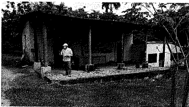
Imagen 4. Vivienda del predio
