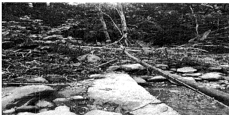
Fotografía 12: Primer paso subfluvial de la línea de conducción entre el “Desarenador Nuevo” al “Desarenador Antiguo”.
