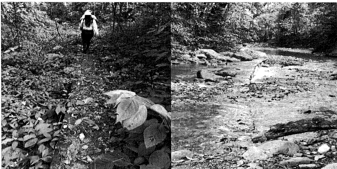
Fotografía 14: Línea de conducción entre el “Desarenador Nuevo” al “Desarenador Antiguo”.
