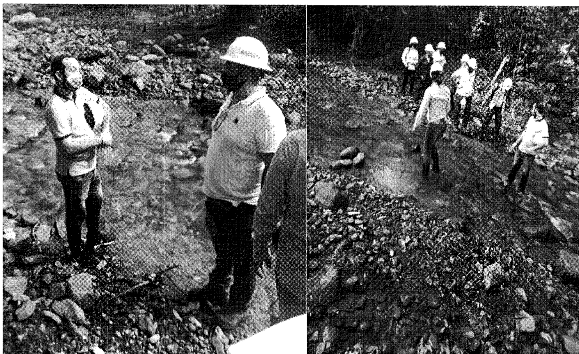
Fotografía 13: Segundo paso subfluvial de la línea de conducción entre el “Desarenador Nuevo” al “Desarenador Antiguo”.
