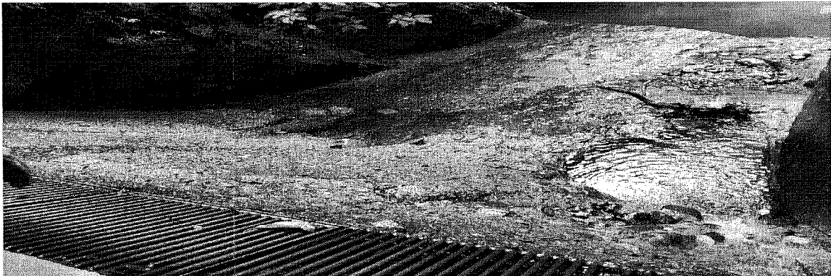
Fotografía No. 4: Estructura actual de la "Bocatoma Nueva", captación del caudal mediante rejillas laterales.
