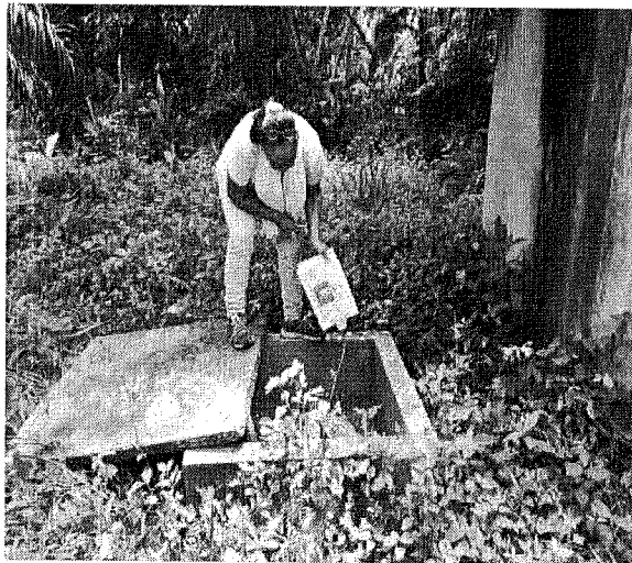
Foto 2. Vista general punto de captación (pozo profundo No. 2) e infraestructura
