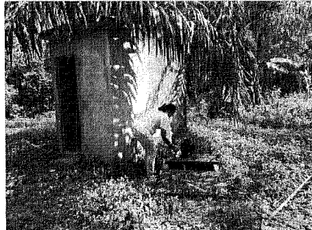
Foto 9. Vista general, infraestructura (caseta de maquinaria).
