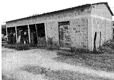
Foto 6. Vista general, infraestructura (vivienda de trabajadores).
