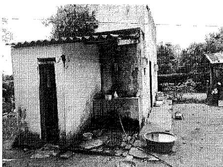
Foto 5. Vista general, infraestructura batería sanitaria.
