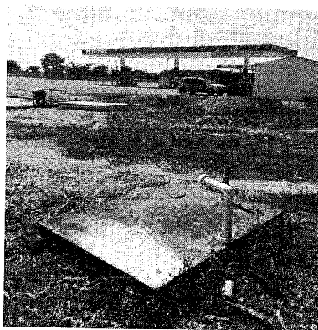
Foto 12: Vista general pozo subterráneo (inactivo) mas cercano al pozo objeto del presente concepto.
