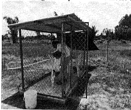
Foto 4: Vista general ubicación punto de captación del recurso hídrico, caseta ubicación pozo profundo.
