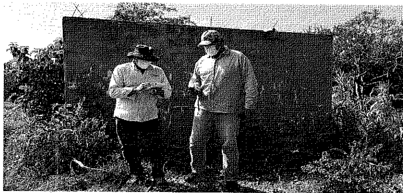
Imagen 5. Tanque de almacenamiento
