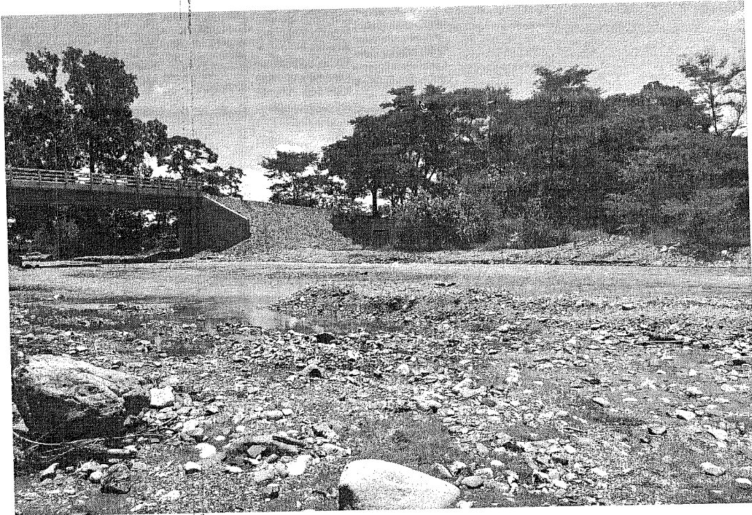
Imagen No. 13: Fuente hídrica de la Quebrada, aguas arribas de la construcción del Puente. Fuente Propia.
