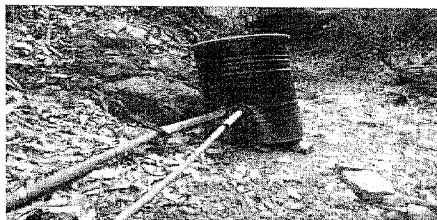
Distribución de las aguas en dos (2) mangueras de 2" y 1"
