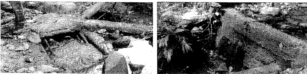
Captación lateral y dique derivador
