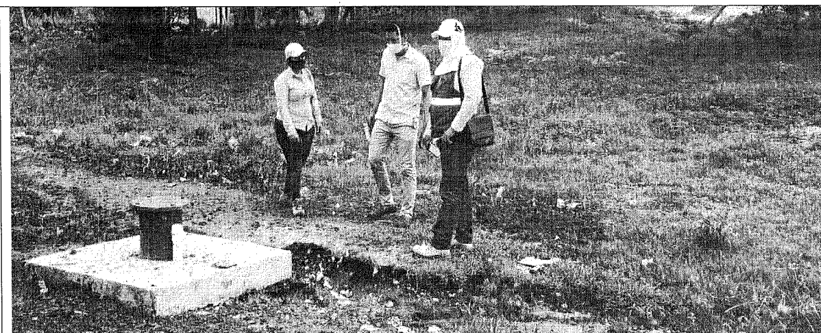
Imagen 2. Pozo de exploración encontrado al momento de la visita.
