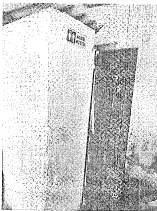
Foto 5. Vista general, área de baños.
