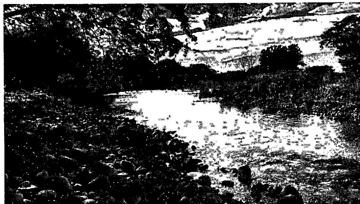
Imagen No. 6: Vestigios de los procesos erosivos y de socavación lateral presente en el punto a intervenir con la ejecución del proyecto en la corriente del "Río Guatapurí" se observa también que el usuario realizó acopio de grava para mitigar la socavación. Fuente Propia.
