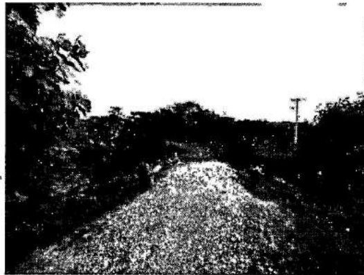
Imagen No. 19: Condiciones actuales en las que se encuentra el Dique "Puerto Viejo". Fuente propia.
