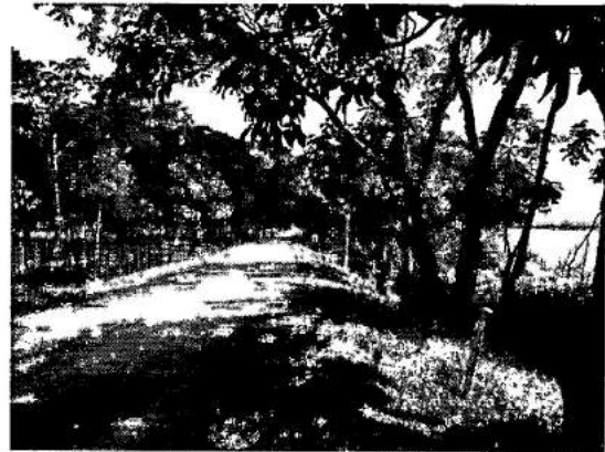
Imagen No. 11: Condiciones actuales en las que se encuentra el Dique "El Contento". Fuente propia.
