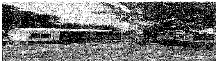
Foto 2. Instalaciones de la vivienda.
