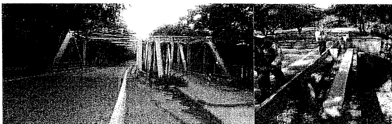
Fotos 1 y 2. El puente actual sobre el río Anime (izquierda). A la derecha un pontón con una tubería (fuera de uso) adosada un costado del tablero.
