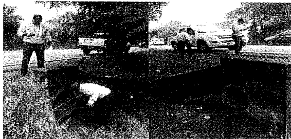
Fotos 1 y 2. Se observa la determinación de las dimensiones y el estado actual de las obras hidráulicas.
