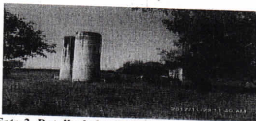
Foto 2. Detalle de los Hidrosilos en desuso
