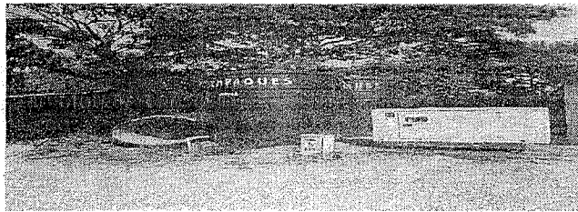
Foto 3. Tanques de almacenamiento
