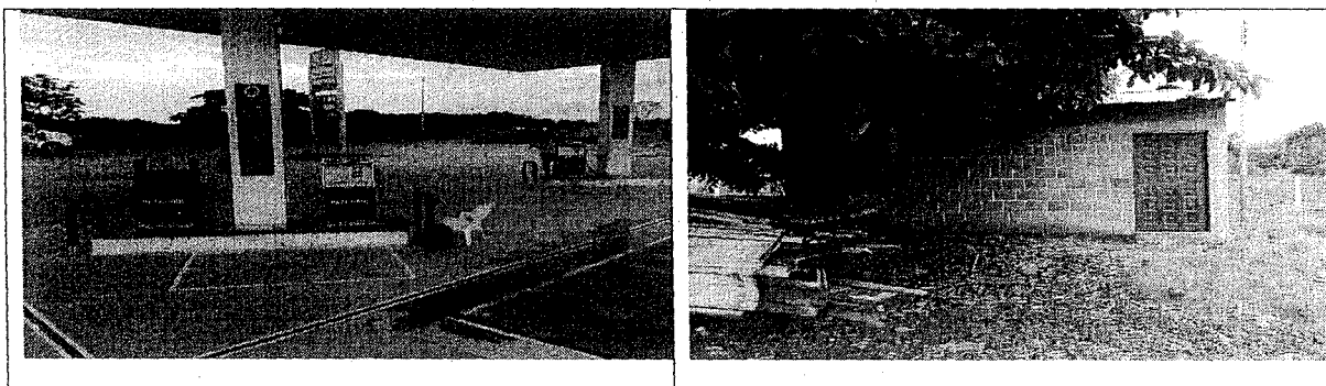
Ilustración 2. Isla y zona de oficina en construcción
