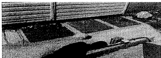
Figura 1. Cajas de retención de sólidos
