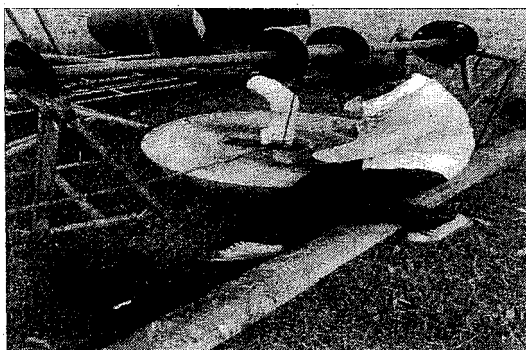
Foto 2. Prueba de Bombeo.
