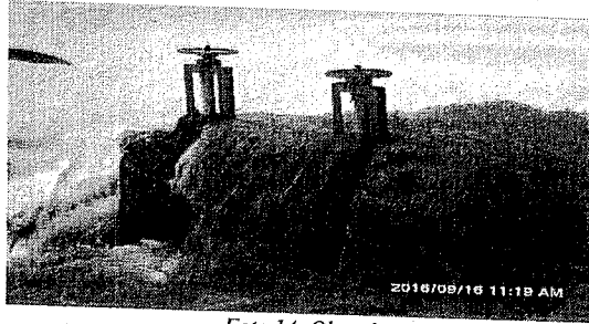
Foto 14. Obra de captación
