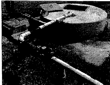
Foto 7. Medidor de caudal Pozo #1.
